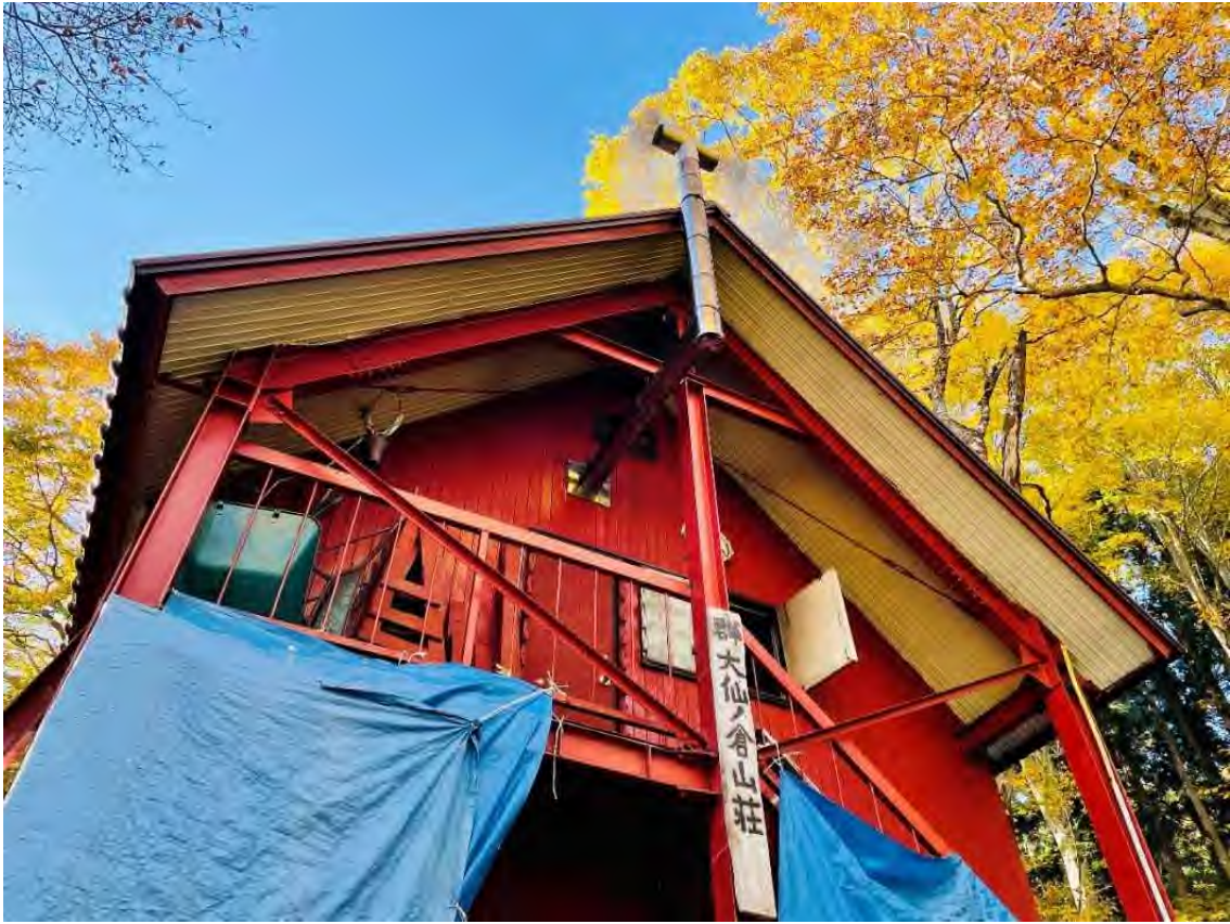
煙突を修理してストーブに火をつけたのち、煙突の先から白い煙が立ち上るのを確かめた。 (今野さん 撮影)
