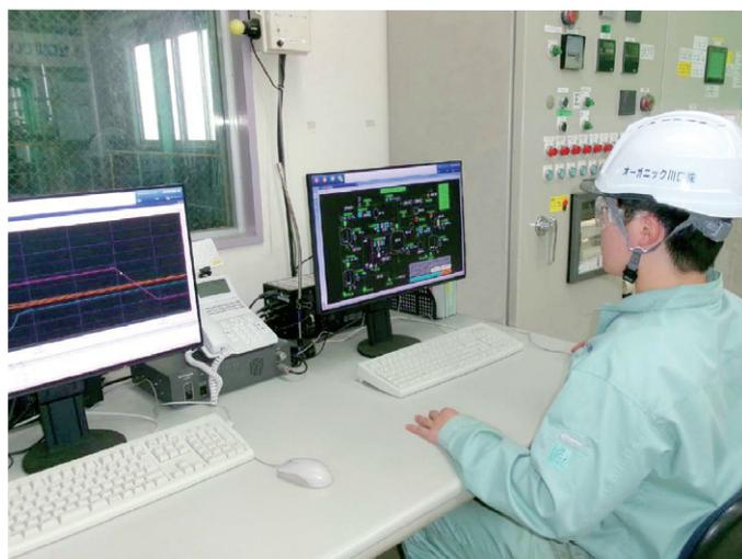
制御室 分散制御システム (Distributed Control System ; DCS)
